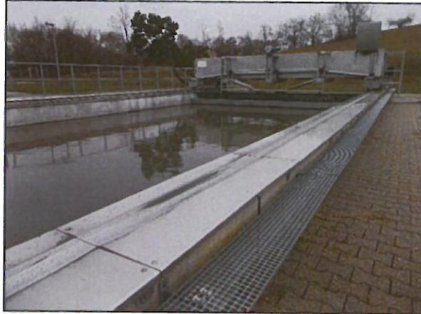
Die Abdeckung weist starke Abnutzungen im Bereich der Laufräder (siehe Bild) auf. Unterhalb der Edelstahlkonstruktion wurde bereits auf der Betonkrone „aufgemörtelt“.
