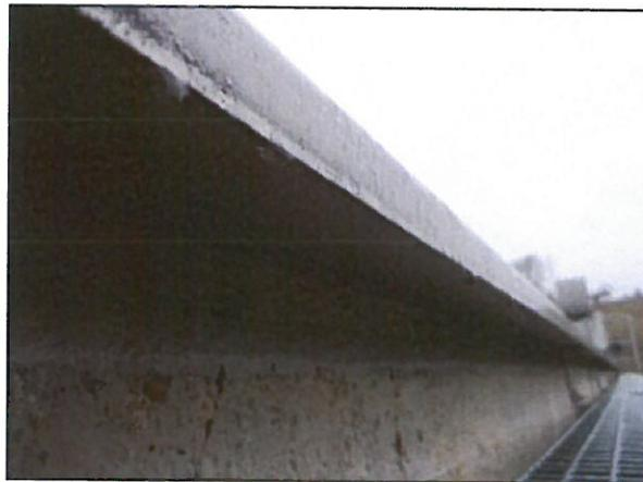
Die Auftragsschicht beginnt in verschiedenen Bereichen zu bröckeln, es kommt zu Ausbrüchen. Daher ist es zwingend notwendig, die Räumlerlaufbahnen zu sanieren. Hierbei ist zu prüfen, ob die vorhandenen Edelstahlabdeckungen wieder genutzt werden können. Ferner muss die Mörtelschicht komplett abgetragen werden, die Betonkrone bewertet und ein Sanierungssystem aufgebaut werden. Eine weitere Überlegung ist, ob unter den Abdeckungen eine Fahrbahnheizung installiert werden soll.
